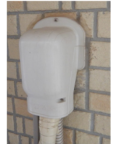
エアコンホースカバー周り
